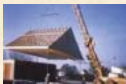
exemple de pré-montage de charpente industrialisée
