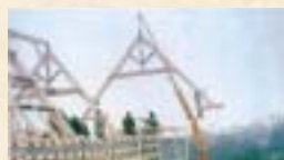
exemple de pré-montage de fermes traditionnelles
